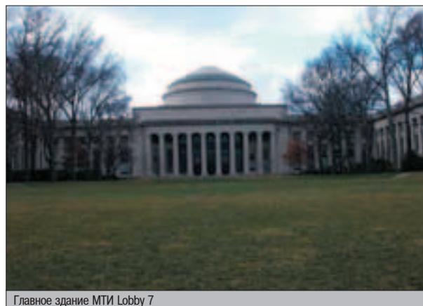
Главное здание МТИ Lobby 7
