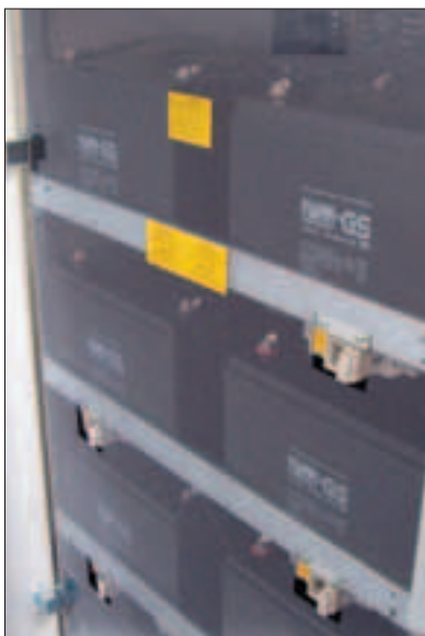
Аккумуляторы в УПСе очень смахивают на автомобильные, только побольше
